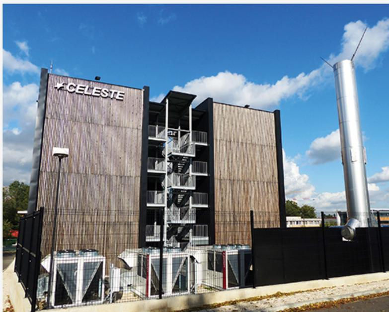
Le datacenter Marilyn, de **Celeste**, illustre la technologie du freecooling avec un bâtiment qui permet à l'air de refroidissement chauffé par les serveurs de s'échapper par le haut.
